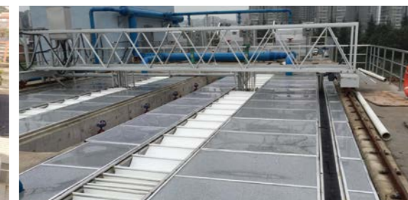
安寧第二污水廠除臭工程
