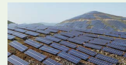
淇縣廟口 100MWp 光伏電站項目
