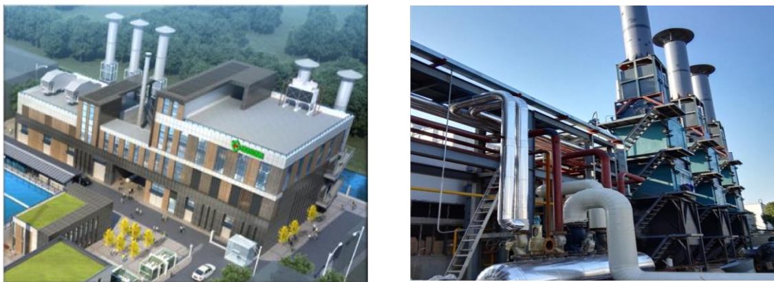
图 4 上海老港工业园区分布式能源项目
