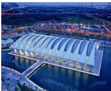
上海东方体育中心金属屋面系统
