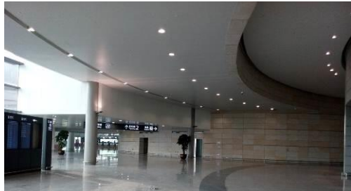
南京南站天花吊顶系统
