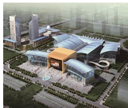
包头国际会议中心金属屋面系统
