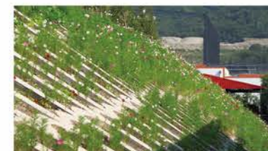
尾矿坝体护坡植被
