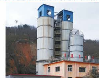
矿山全尾砂膏体充填设施
