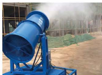
项目建筑工地采用雾炮进行喷雾降尘
