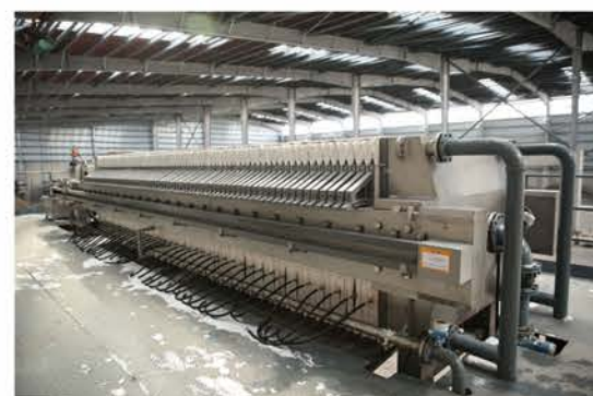
氰渣破氰工艺设施
