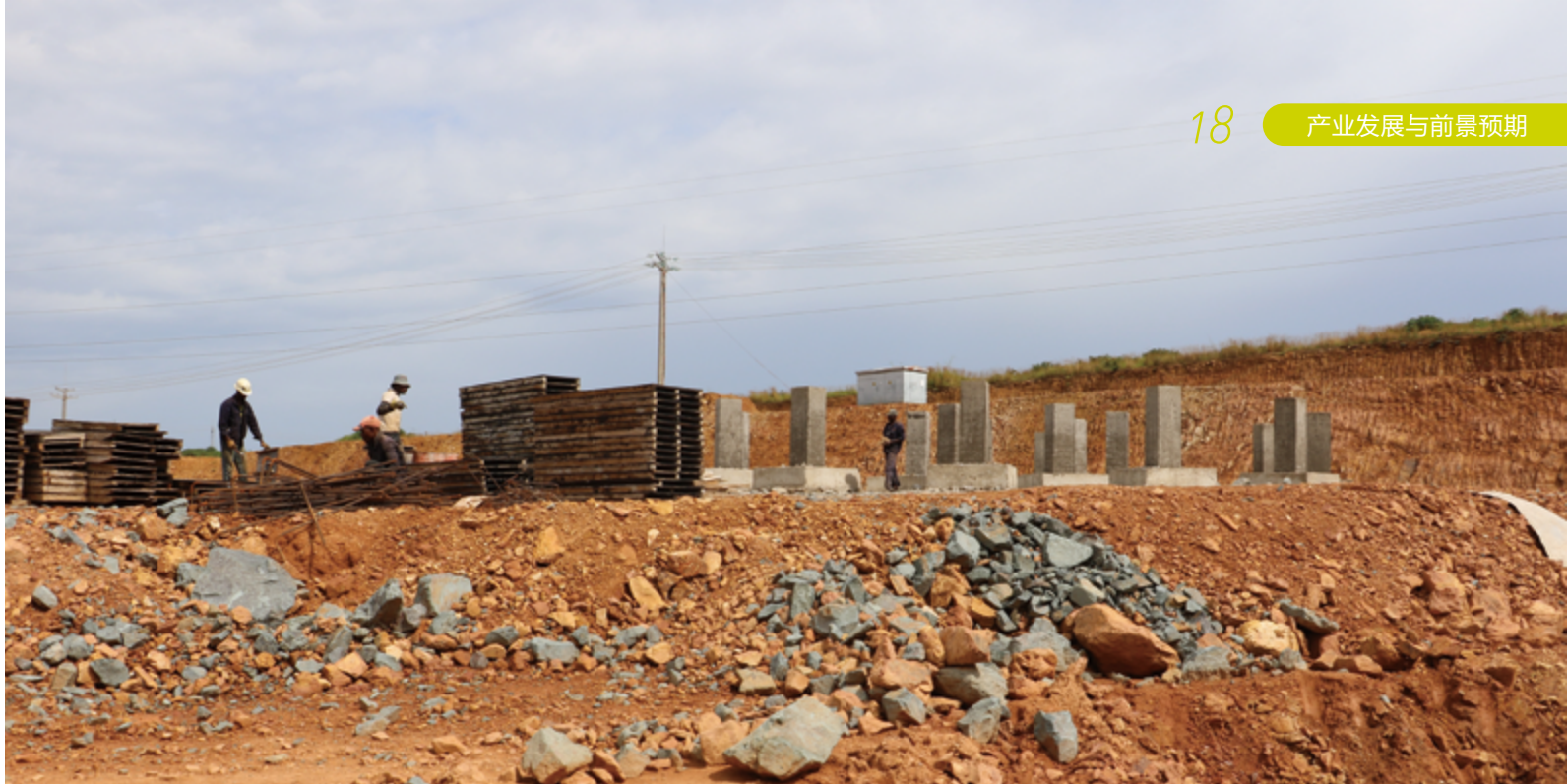
鹏欣资源SMCO钴项目正在紧锣密鼓得建设中 ▲
