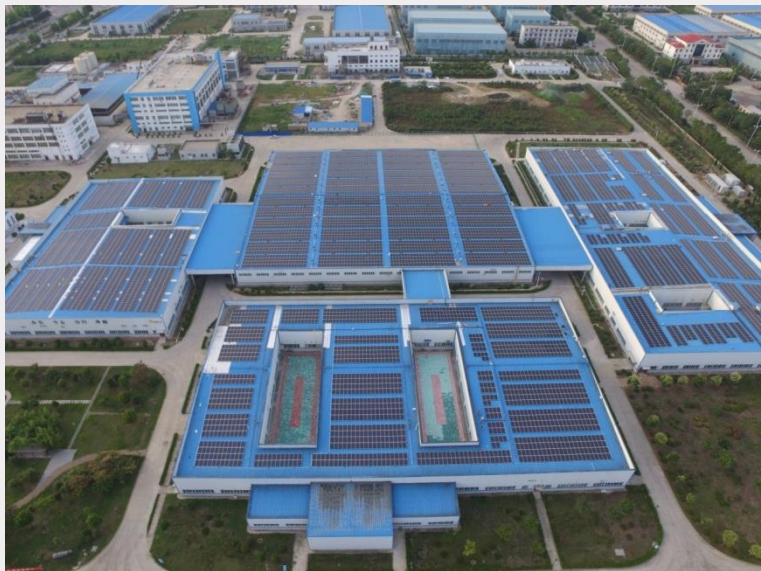
华润金蟾屋顶光伏发电全景
