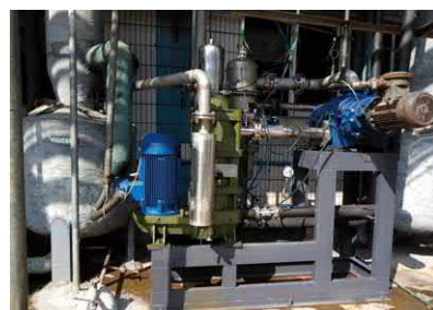
螺杆真空泵代替原水环真空泵
