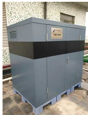
冷却水循环系统
