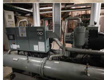
空调冷水机组改造
