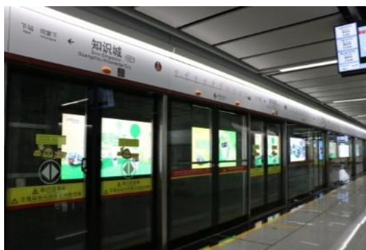
站台屏蔽门系统 (PSD)
