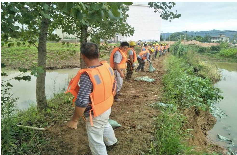
安徽路港 G347 普枞段 LJ-06 标项目部防汛救灾现场
