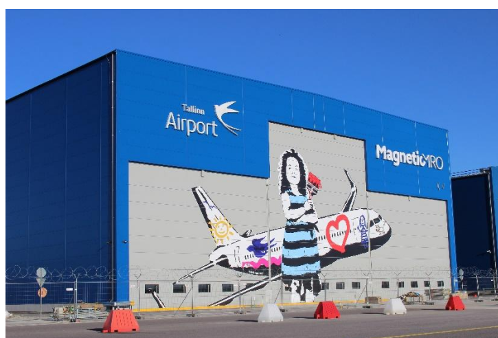
MMRO 位于塔林的飞机涂装机库
