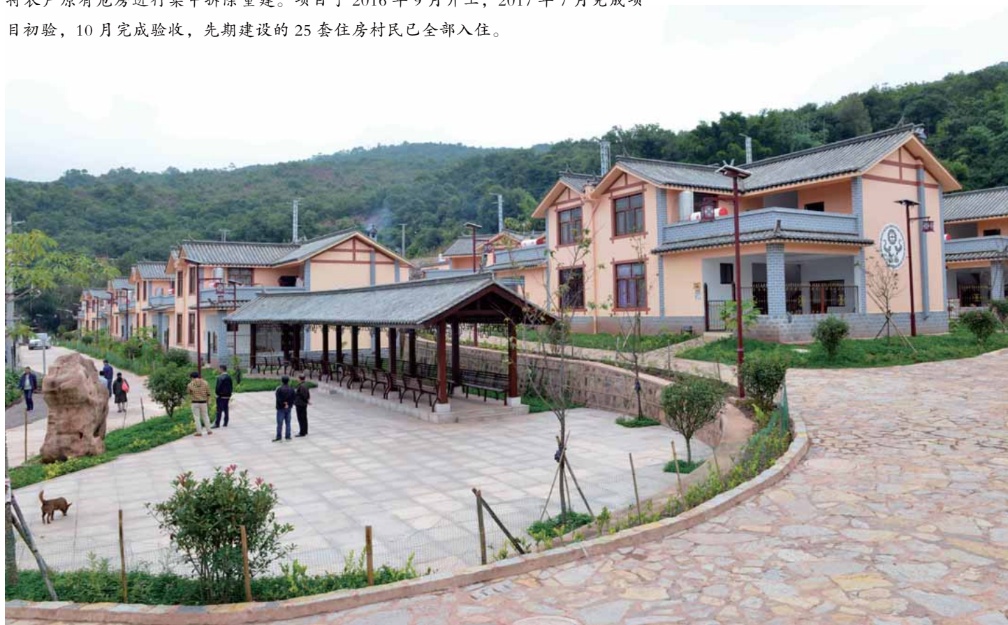
磷化集团援建的昆明市晋宁区夕阳彝族乡高粱地村委会赖家新村整村拆除重建扶贫项目
