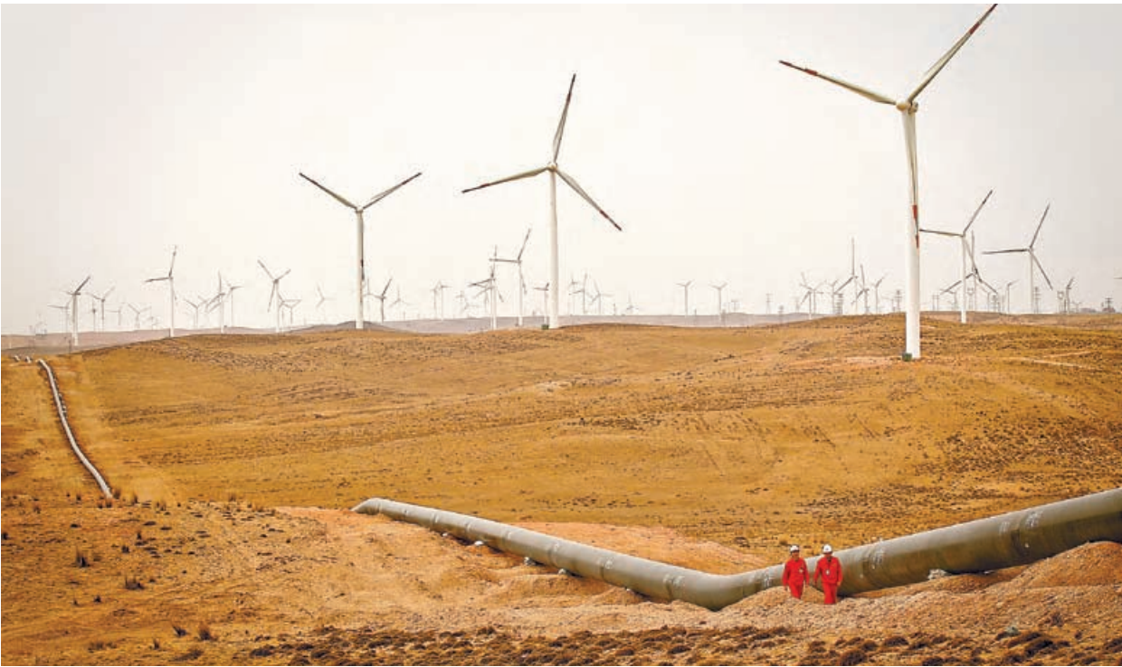
西气东输三线（西三线）中靖联络线管道建设——管道穿越毛乌素沙漠
