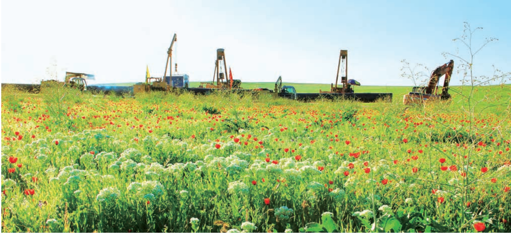
中亚天然气管道C线绿色环保施工，保护当地生态环境
