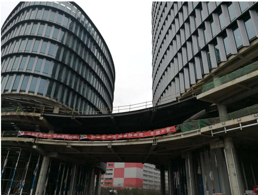
图为公司吴泾办公大楼施工现场悬挂的安全警示横幅
