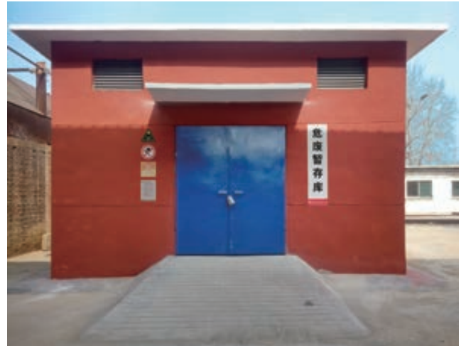
危险废物暂存库
