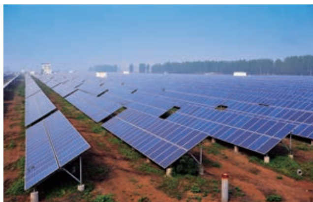
塌陷区治理后用作太阳能光伏电站
