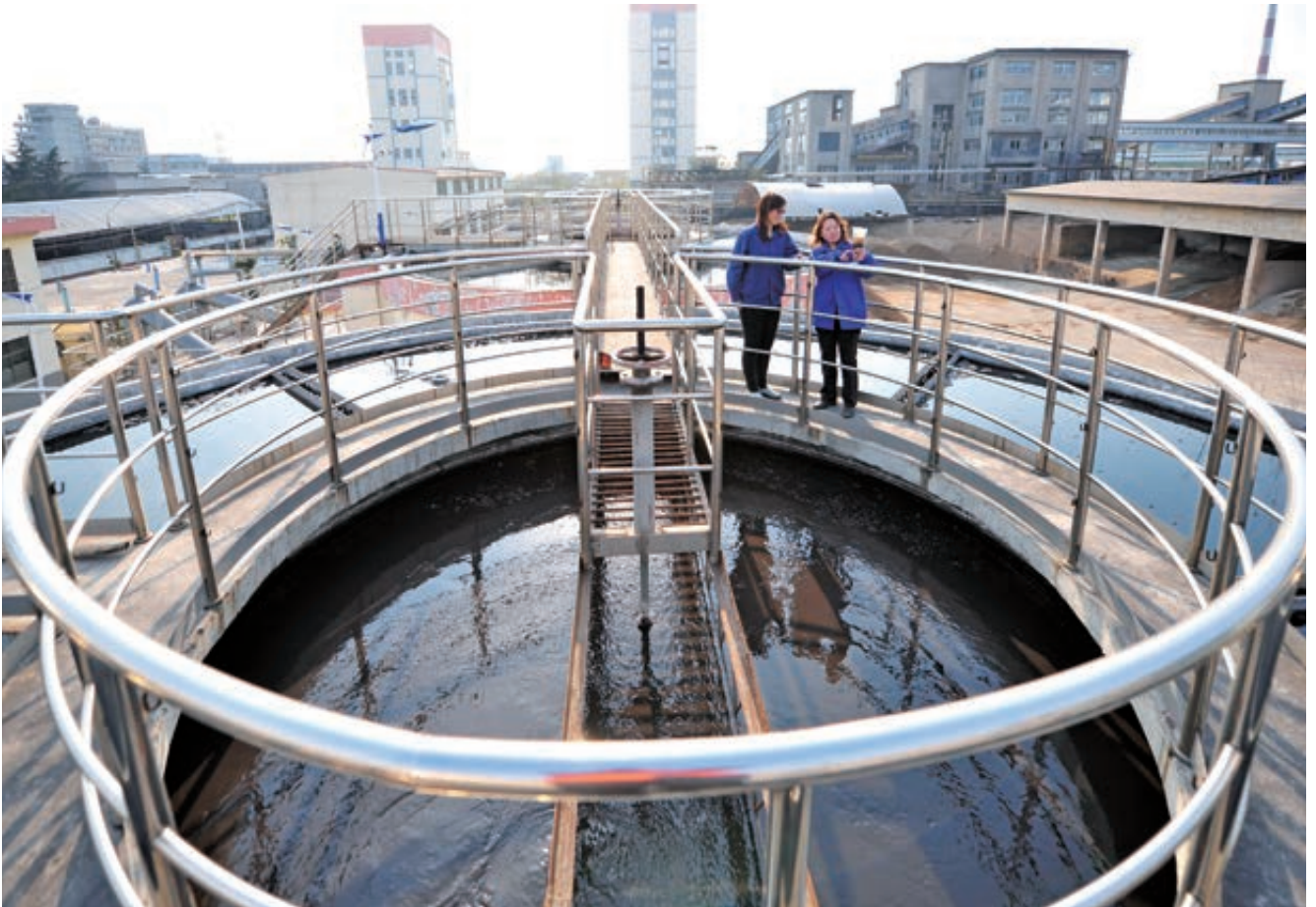
矿井水高效澄清池
