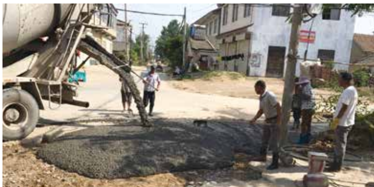
红楼村路面修建
