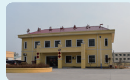
华冠环保下属 14 个地表水厂之一——位于雄安新区的安新县地表水厂
