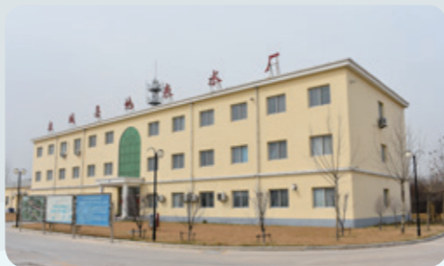
位于雄安新区的容城县地表水厂
