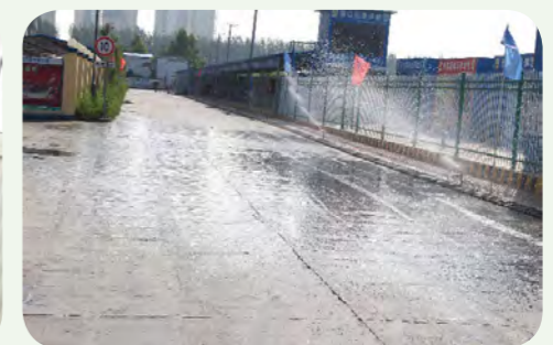
对施工现场道路进行洒水降尘 Sprinkling water to reduce dust
