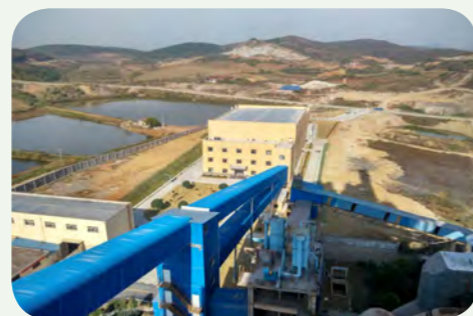
宜城水泥窑项目 Yicheng Cement Kiln project
