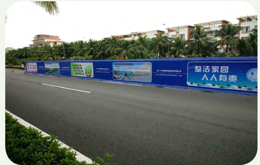
道路施工隔音墙 Soundproof wall
