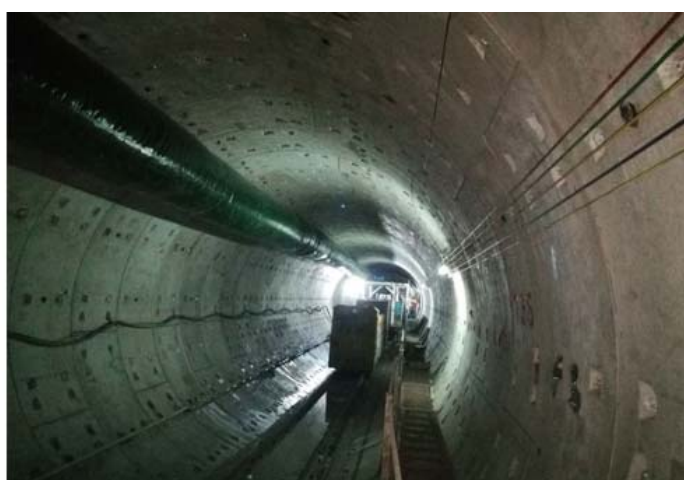
图：穿越京杭大运河的盾构区间
