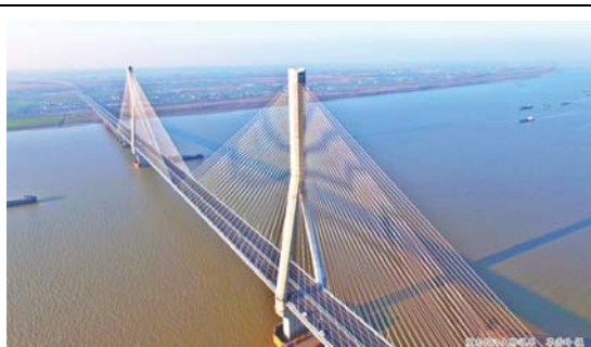
望东长江大桥——世界最大跨度的叠合梁斜拉桥
