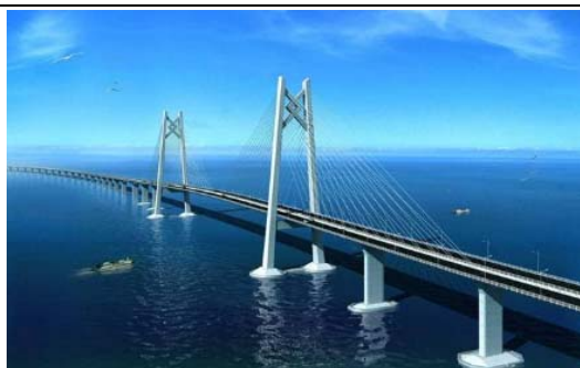
港珠澳大桥——超级工程
