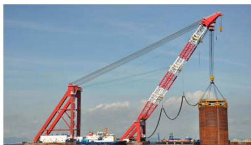
12000 吨起重船成功吊装港珠澳大桥岛隧工程海底沉管最终接头，荣获第十九届中国国际工业博览会“特别荣誉奖”
