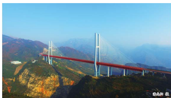
北盘江大桥——世界第一高桥
