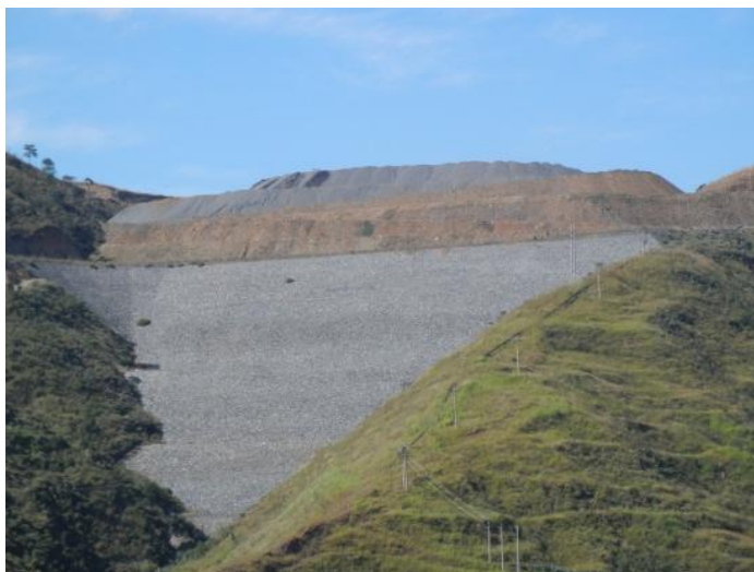
水土保持措施渗透坝排渗盲沟
