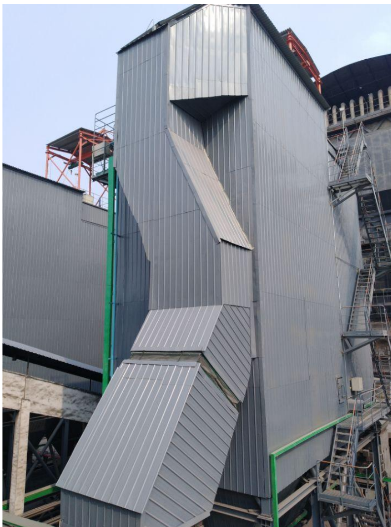
德阳公司热电锅炉尾气烟尘改造项目
