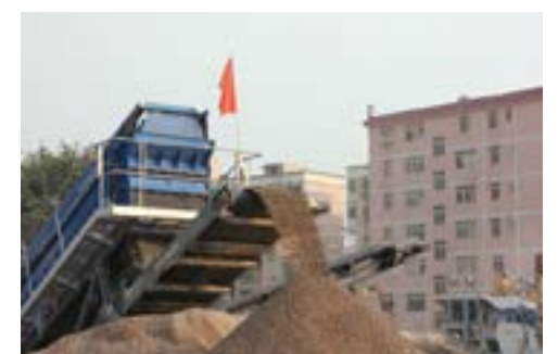
罗湖棚改建筑废弃物粉碎筛分现场
