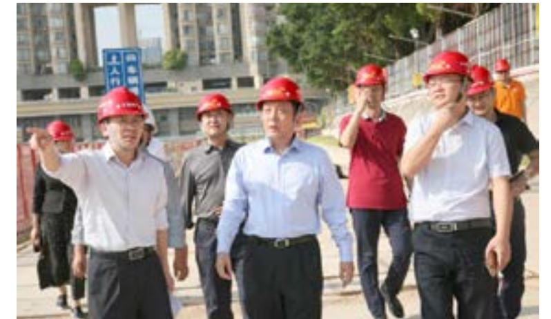
集团领导检查工地安全生产情况
