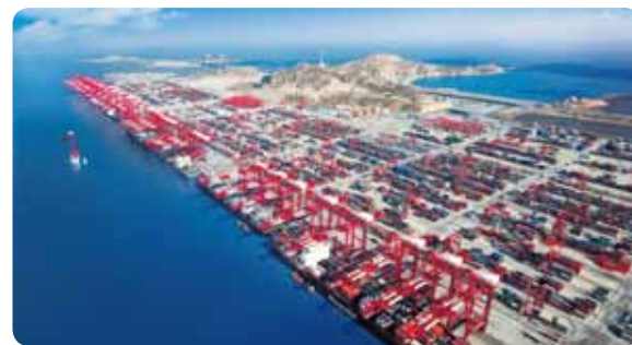
上海洋山深水港项目
