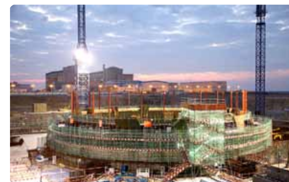
华龙一号项目建设工地
