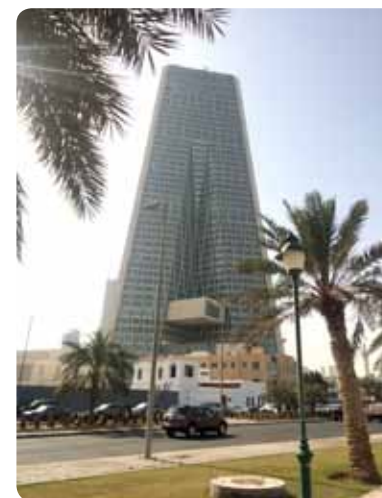
科威特中央银行新总部大楼项目
