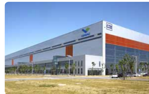
C919 大型客机部装厂房项目
