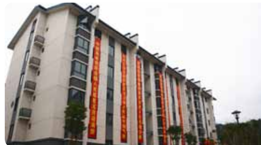
永泰鼓樟新苑灾后重建安置房正式交付
