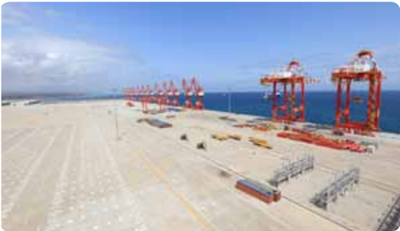
吉布提多哈雷港口项目
