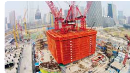
超高层建筑智能化施工装备集成平台
