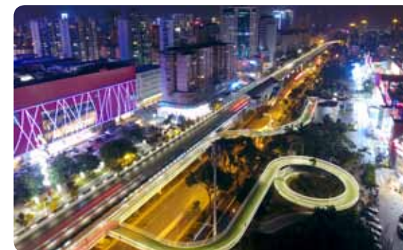
中建钢构厦门市空中自行车快速道示范项目
