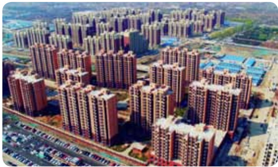
北安河定向安置房项目
