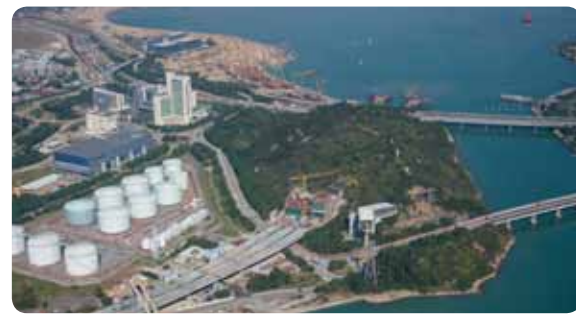
港珠澳大桥项目
