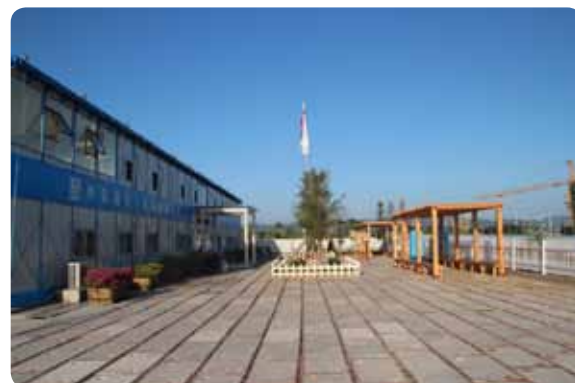
混凝土预制块道路
