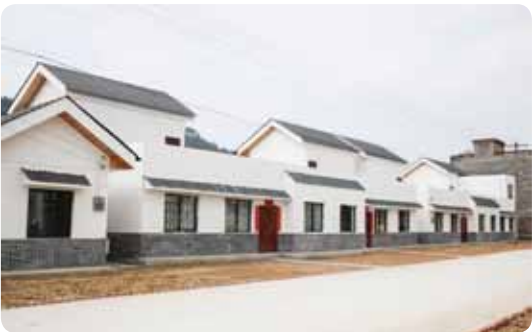
绿色钢构民居项目
