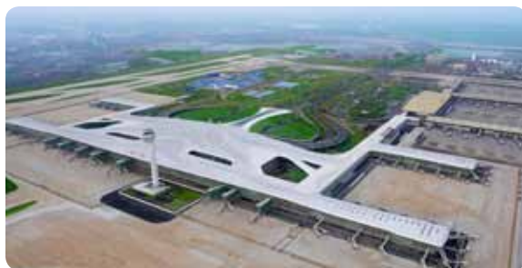
武汉天河机场 T3 航站楼项目
