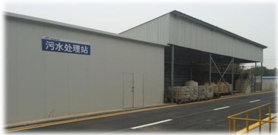
上图:废水处理站
