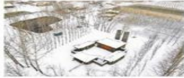
铁汉生态某大型项目施工现场
