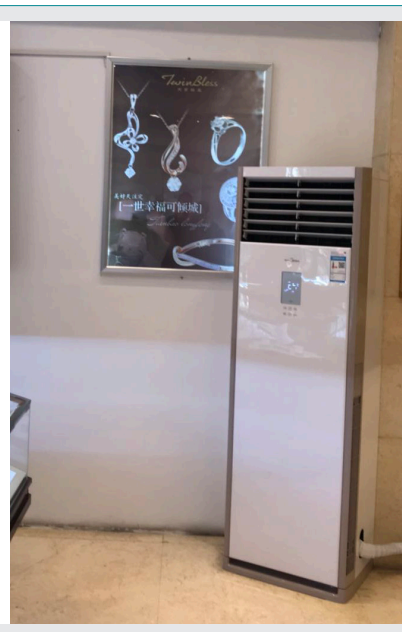
中央空调改造
