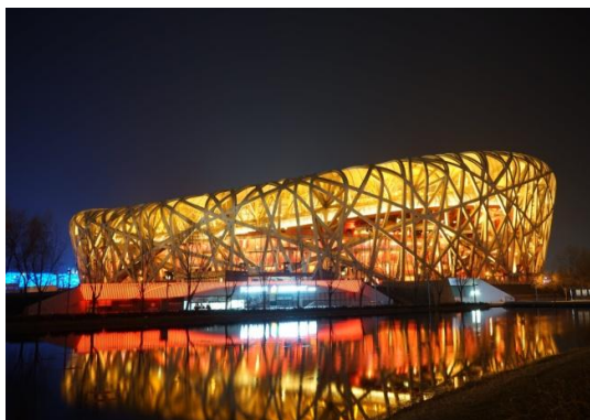
公司产品在奥运体育场馆的应用
