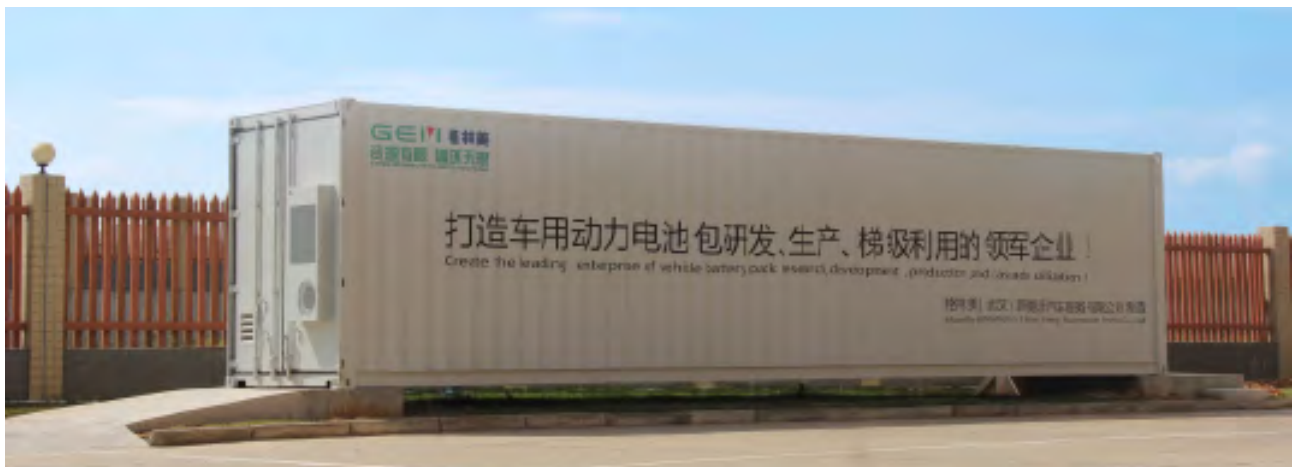
退役动力电池梯次利用产品——集装箱式储能电站
