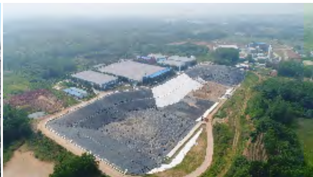
扬州宁达杰嘉固废填埋场
