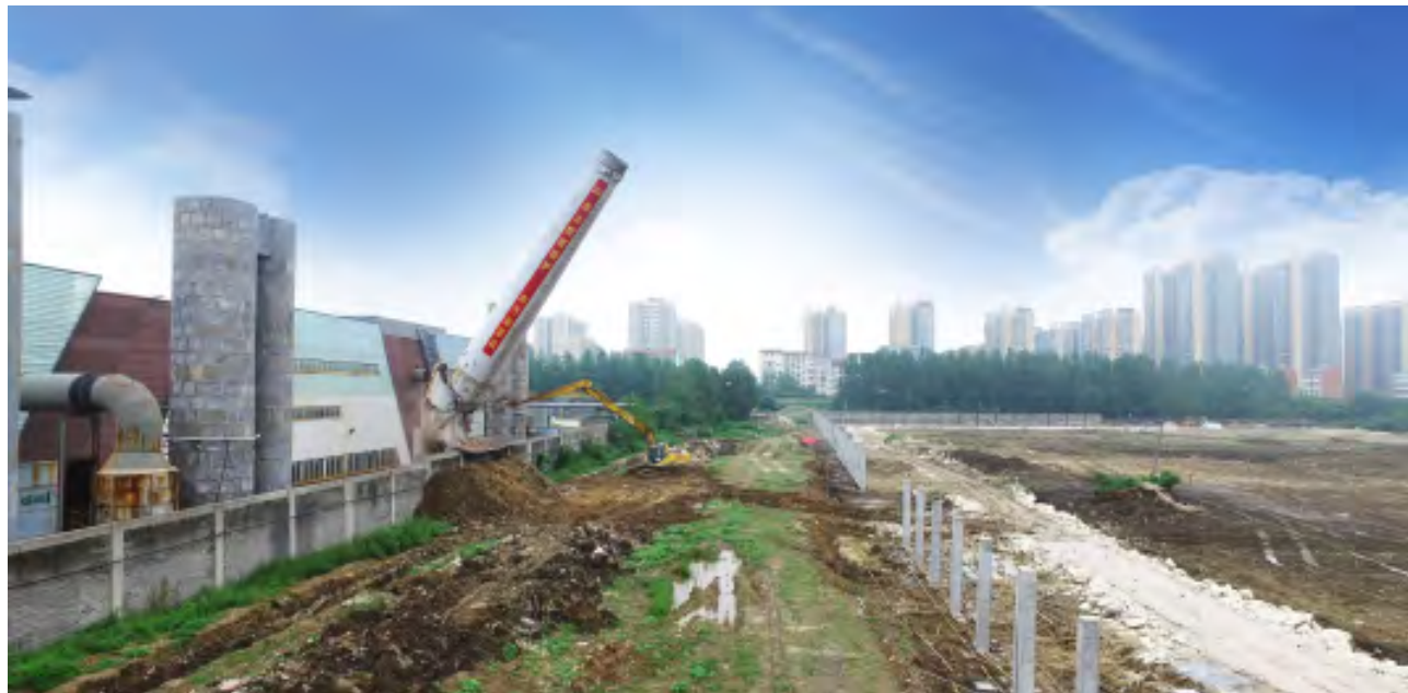
拆除燃煤锅炉
