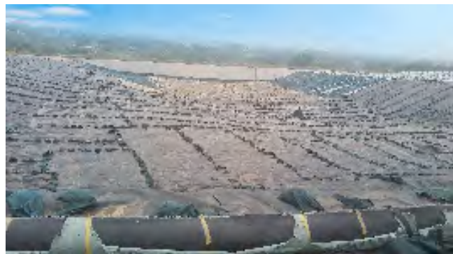
鄂中固废填埋中心
