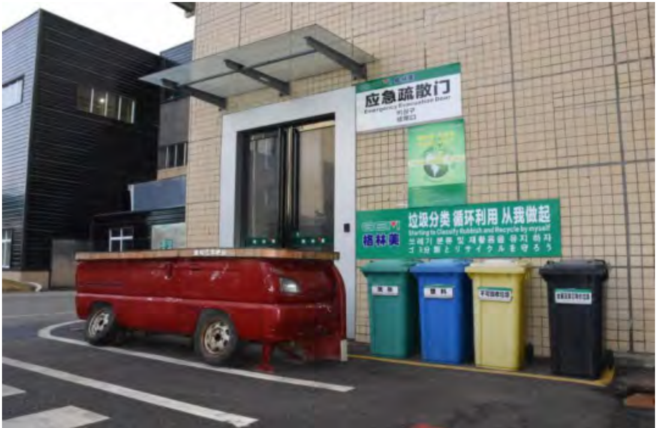
荆门园区生产区垃圾分类回收区
