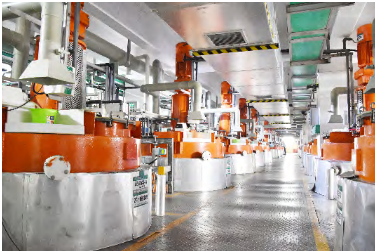
荆门园区三元动力电池材料生产车间
