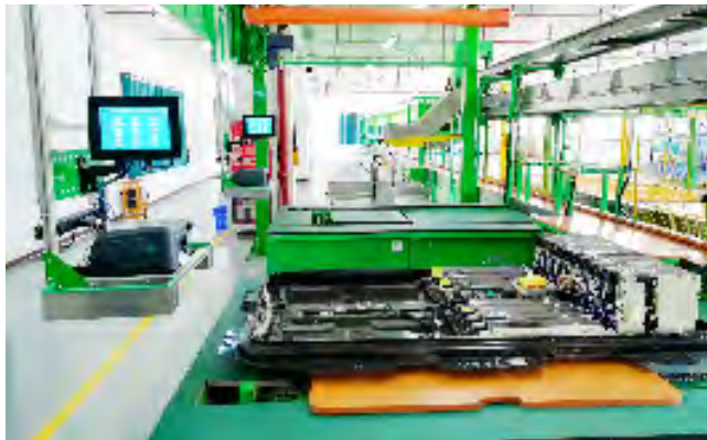
无锡园区退役动力电池包智能拆解线
