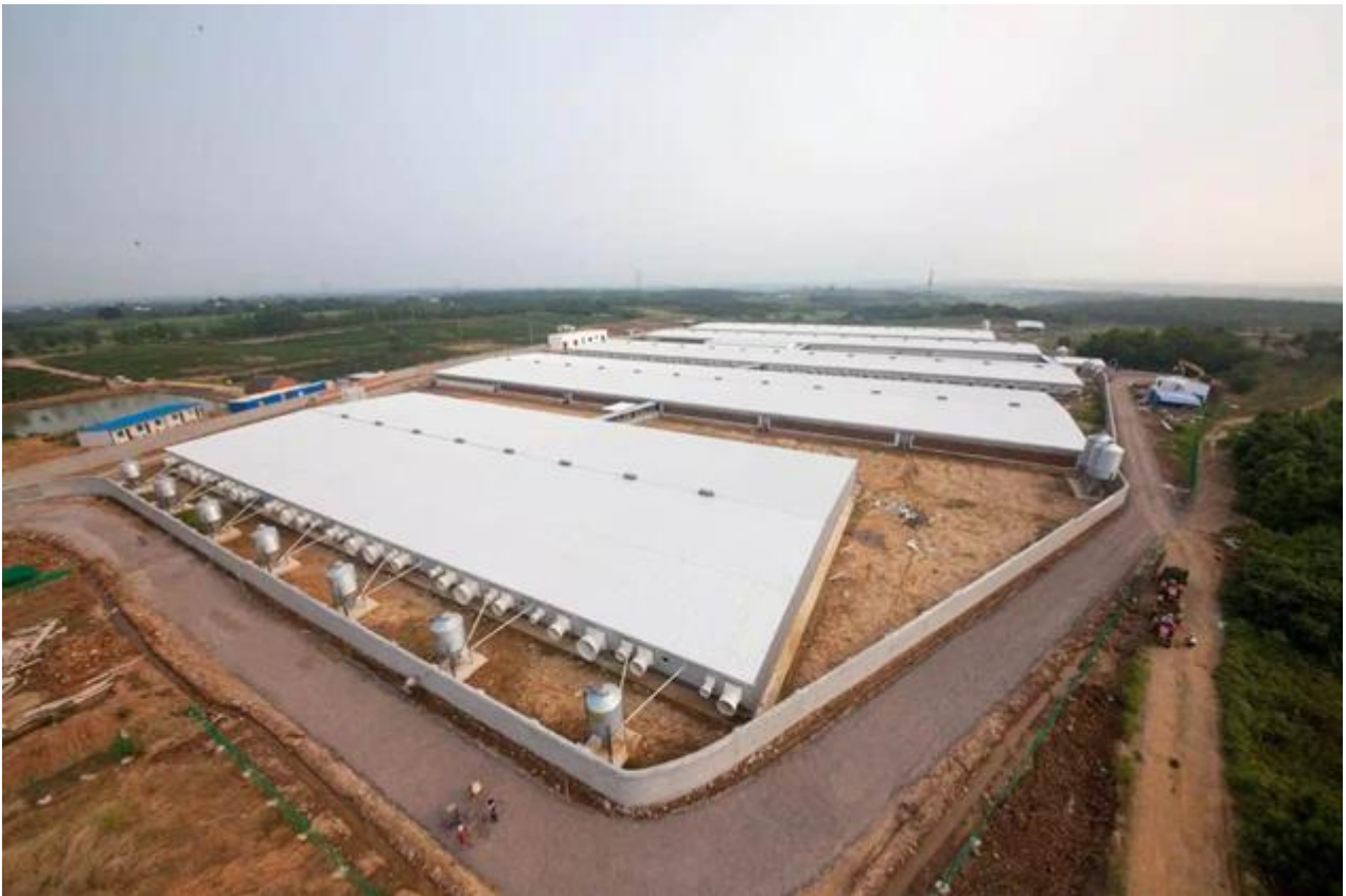
（图为天邦开物建设中的猪场）
