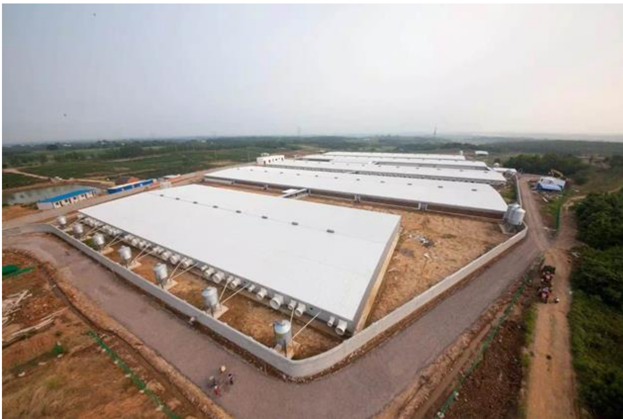
（图为天邦开物建设中的猪场）
