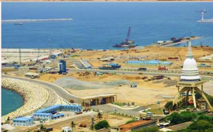
建设中的 斯里兰卡 科伦坡港口
