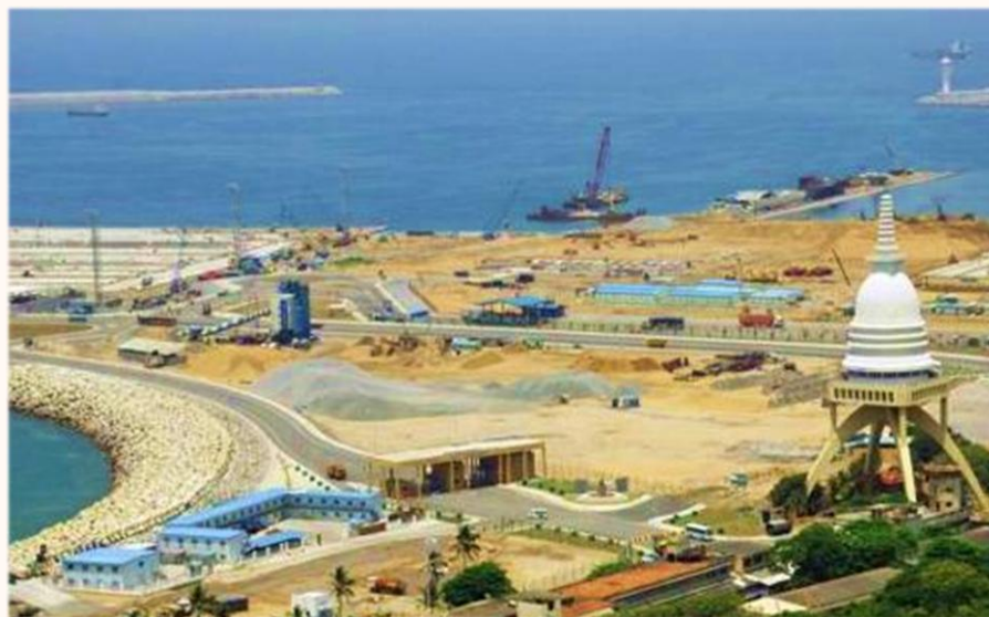
建设中的 斯里兰卡 科伦坡港口
