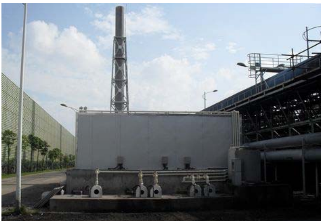
生物箱式滤池实例 图 5.5-4
