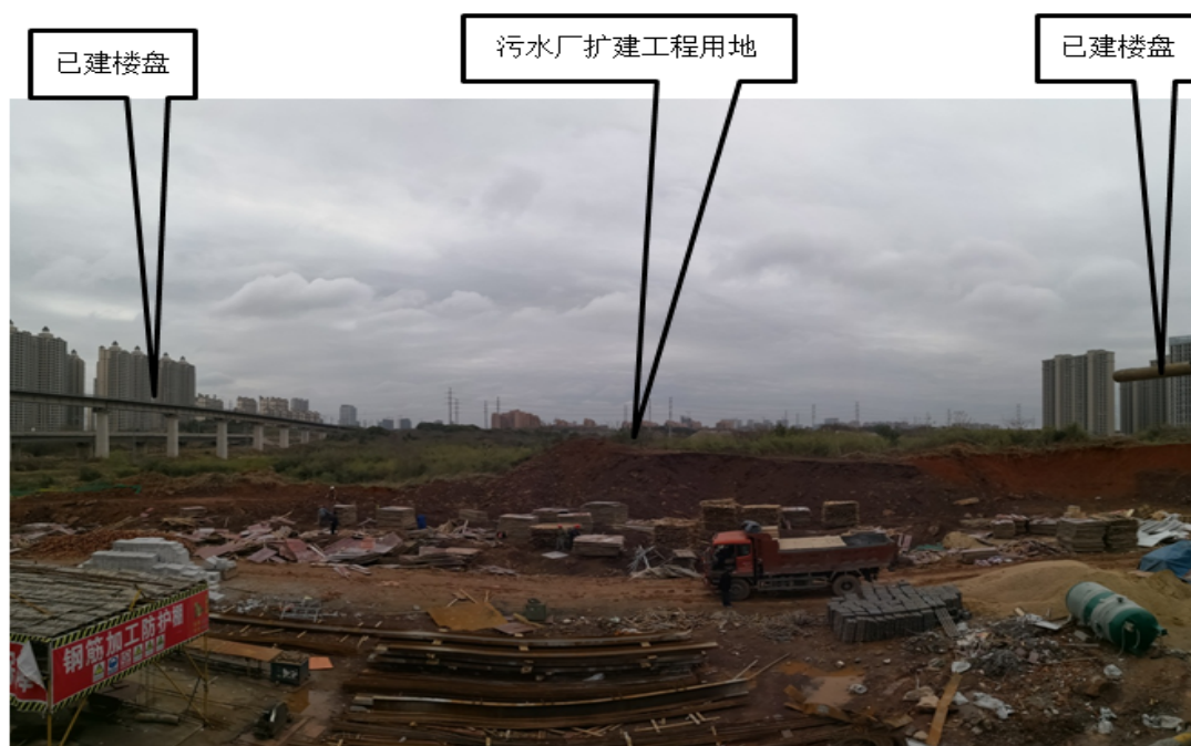
污水处理厂二期扩建工程拟建厂址 图 4.2-2
