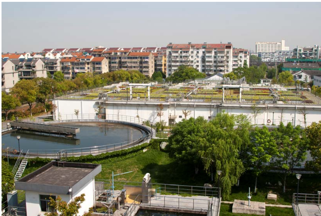
地上式全封闭——苏州市城东污水处理厂 图 4.1-1
