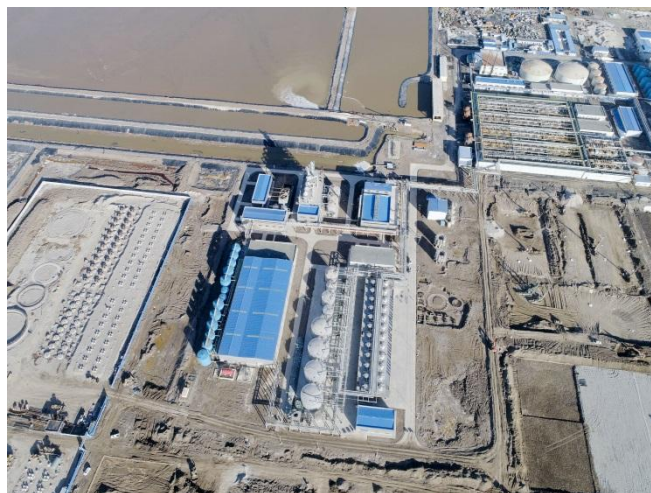
2万吨碳酸锂装置施工现场
