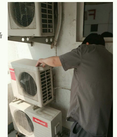
清洗空调机组，提升设备工作效率
