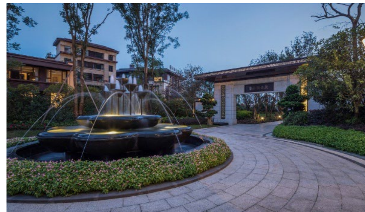
高质量的公共区域施工
