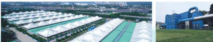
高冠石污水厂加盖除臭工程，加盖面积达9.26万㎡，臭气最大处理量12.3万m 3 /h
