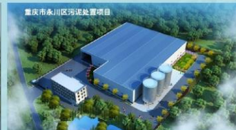
投资9986.16万元，采用污泥制砖和污泥资源化利用工艺，污泥处置规模100吨/天
