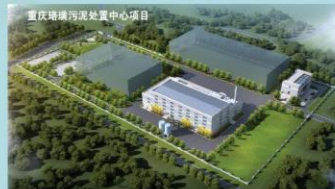
投资1.73亿元，采用干化+焚烧厂焚烧工艺，污泥处置规模600吨/天
