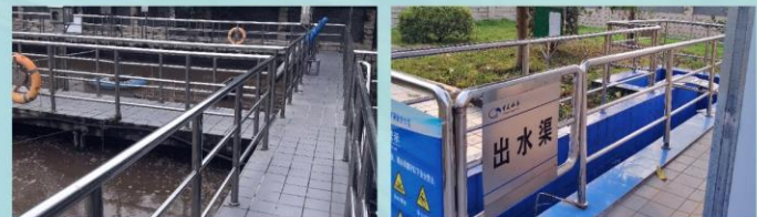
西山坪污水处理厂于2004年4月开工建设，2004年12月投入运行，总投资1000万元，占地4600㎡，设计规模1500m 3 /日，采用CASS工艺，污水管网7.36公里，服务人口10700人。
