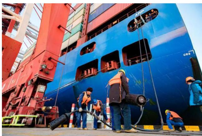
联盟国际公司岸电系统额定输出容量为4000kVA，岸电系统可分别为两个泊位的10万吨级船舶供电，岸电电源在实施与船舶电源连接、退出及转换过程中可以实现船舶不断电，做到无缝切换。本次“连船试验”显示：岸基供电系统共连续为船舶供电20小时，稳定输出
