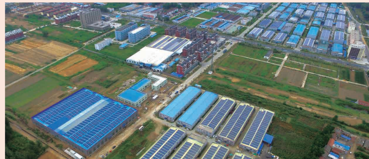
△ 江苏省泗阳县 15MW 分布式屋顶光伏扶贫发电项目
