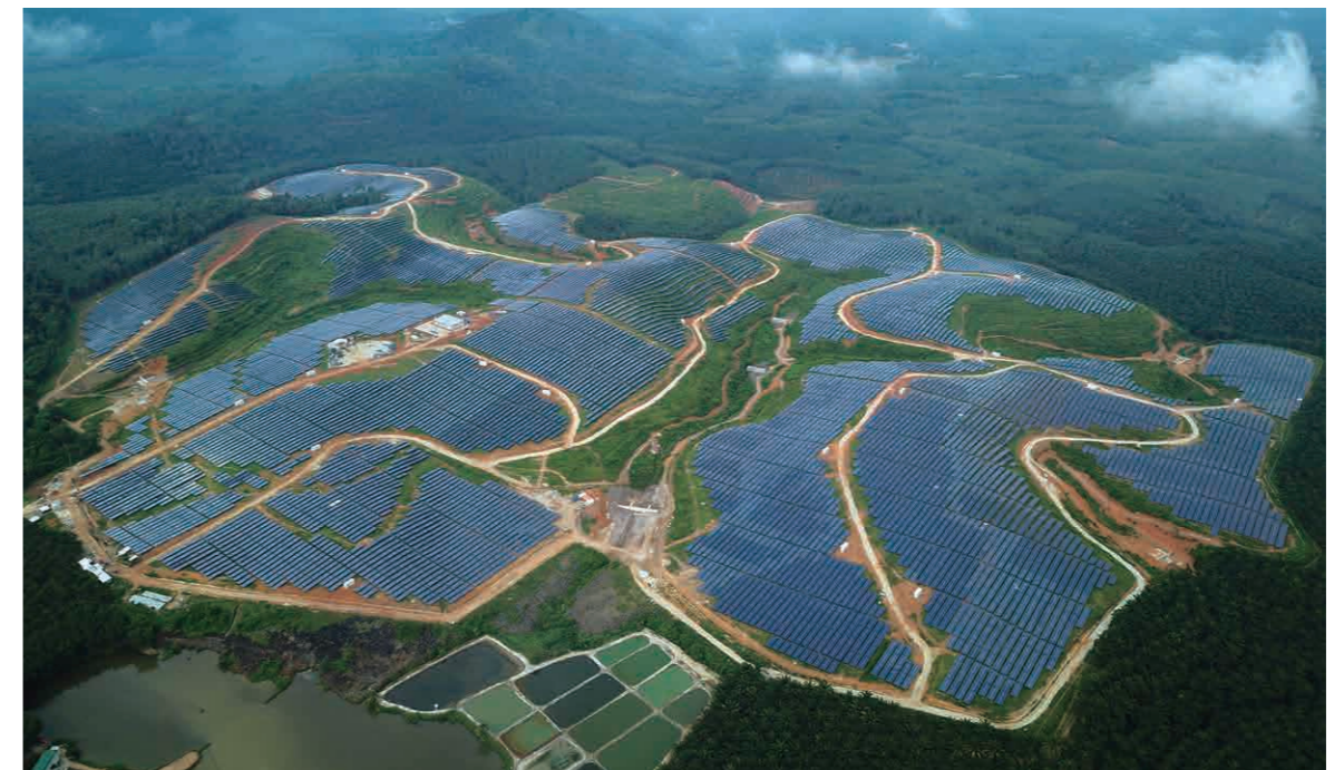
△ 马来西亚 62MW 光伏电站项目
