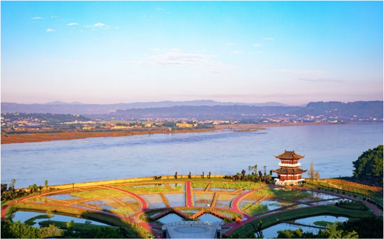
五粮液园区废水处理生态湿地
