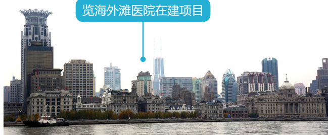
览海外滩医院在建项目
