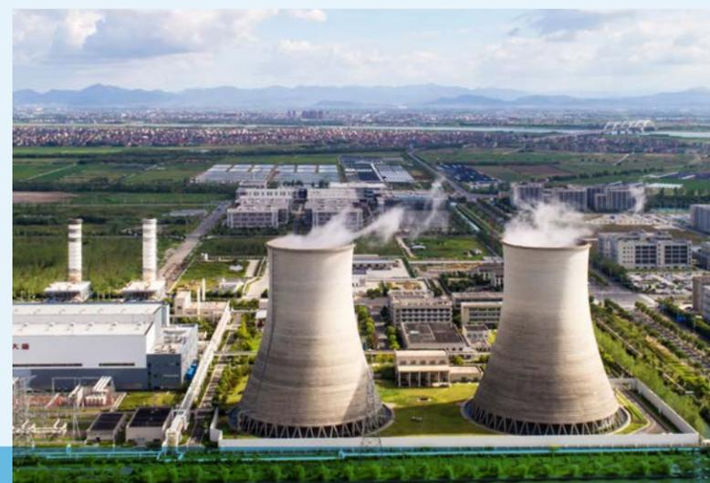
浙江绍兴江滨热电公司一期工程装备两台 452 兆瓦三菱 9F 级单轴燃气机组，是浙江省 14 个天然气热电联产抢建项目之一，2018 年正式实现区域全面供热。项目先后获得“中国建筑工程鲁班奖”“全国安全文化建设示范企业”等荣誉，在同类机组中保持先进水平、在浙江区域燃机对标领先，对优化浙江省电源结构、满足区域热力需求发挥重要作用。
