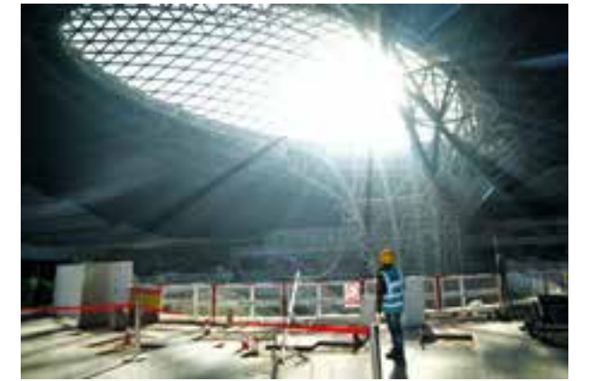
本行北京分行为大兴新机场建设提供全方位金融服务
