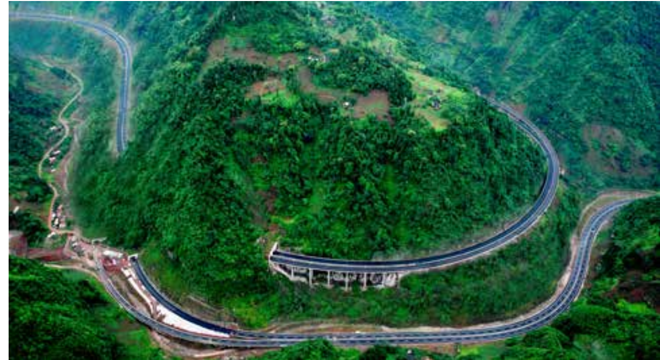
本行融资支持的水麻高速公路项目首创螺旋展线桥隧路段
