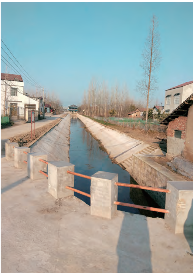
在湖北公安县金牛村修建的道路及水渠
