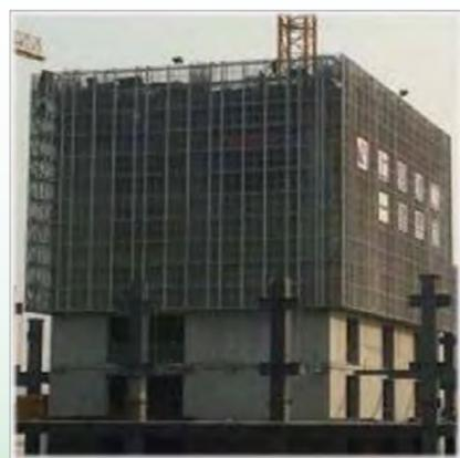
浦东金融广场项目地处陆家嘴区域中心地带，周边为高端商业体、写字楼及居民区，现场安全文明施工的标准极高。为满足绿色施工的要求，公司决定采用新型阻燃装配式整体提升脚手架。
