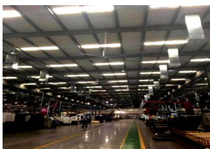
图 车间内工业风扇、降温送风管网
