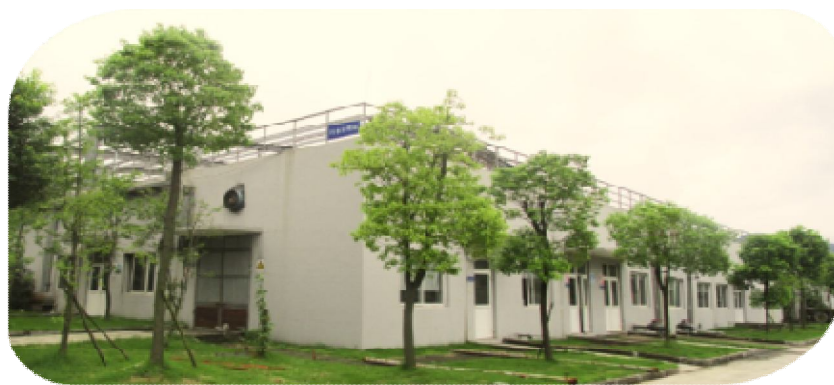
• 生活垃圾渗滤液处理
