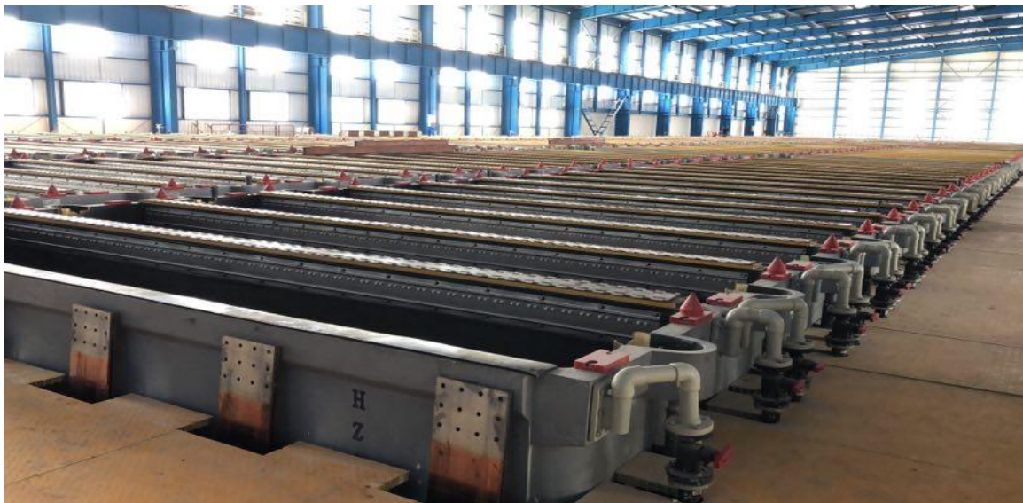
北矿灵宝金城铜业 16 万吨电解铜项目现场
