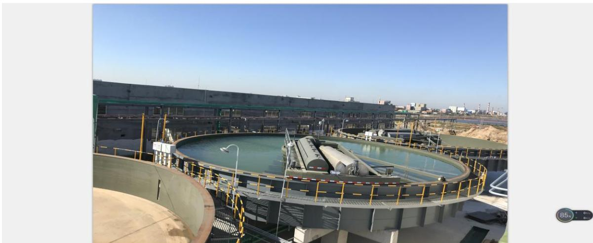
图为：山东海化股份有限公司纳滤精制卤水工业化一期项目卤水调输单元，最大产能 10.35 万吨/天，选用 MST-16 浅层离子气浮设备 3 台，单台气浮处理水量最大 34500m<sup>3</sup>/d/台。
