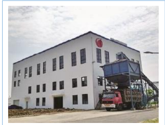
公司完成梅村等项目污泥处置价格调整。
