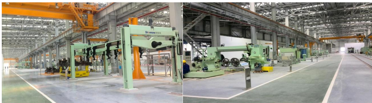
图：大功率机车检修基地
