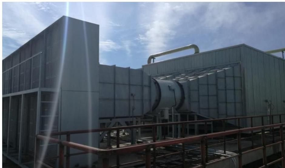
1. 报告期内，公司顺利实施建设了中石化中天合创高盐废水结晶项目。该技术针对国内高含盐蒸发母液处置，解决了蒸发塘、暂存池废水难处理的问题，具有工作温度低，进水水质要求低；卤水浓度可操控；能量利用广泛，电、蒸汽及余热等皆可利用的特点，特别是具有其他蒸发结晶工艺不可比拟的低要求进水条件，为高 COD、高硅、高硬等复杂废水处理提供了先进的处理方法。
