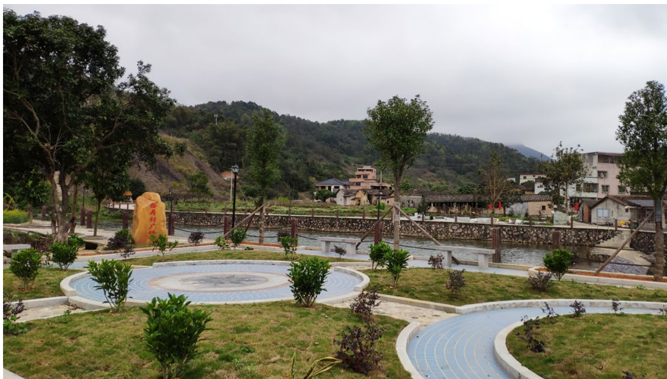
▲ 丰顺县北斗镇拾荷村广场建设实景图
