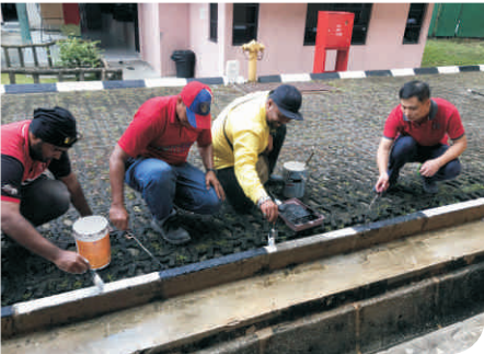
与当地施工人员一起施工
